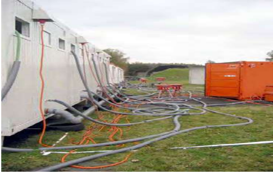
شکل ۱۹-۲ سرویس بهداشتی با واحد توزیع و جمع‌آوری آب و فاضلاب در بیمارستان سیار
