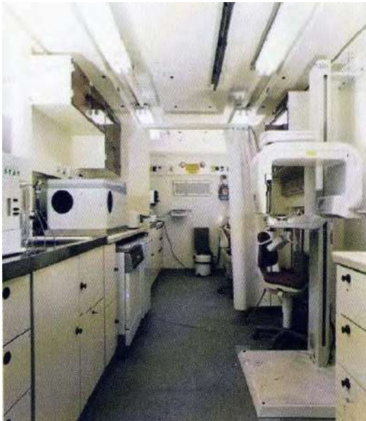
شکل ۲۰-۱ سقف کاذب در یک واحد سیار پزشکی
