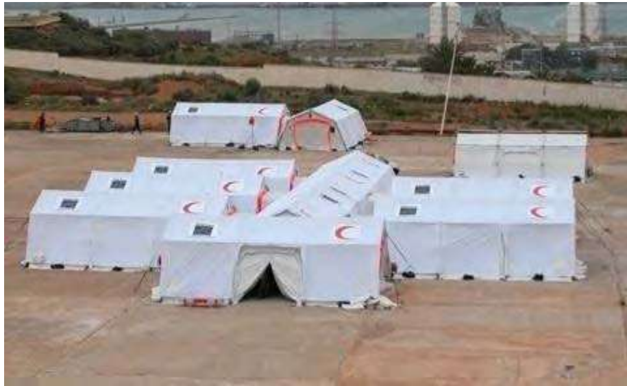
شکل ۱۲-۴ یک واحد بیمارستان سیار چادری با توجه به کریدورهای میانی بیمارستان و نحوه اتصال کلی چادرها به کریدورها و خود کریدورها با یکدیگر
